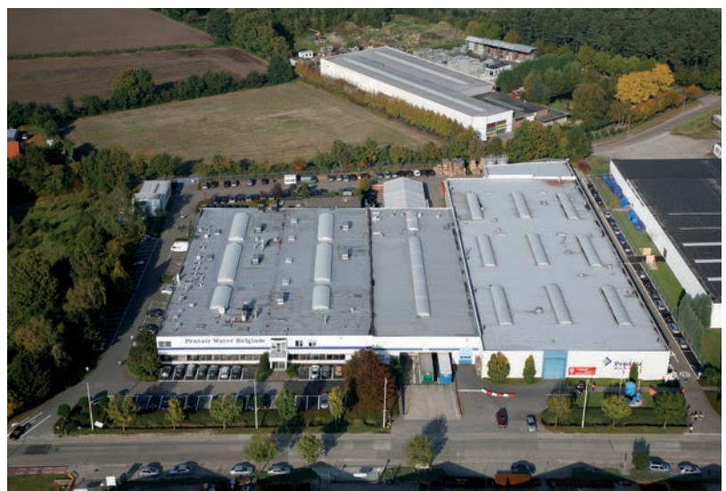
Site de production de Structural Herentals. Belgique
